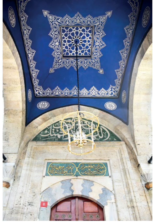
2013 yılındaki restorasyon sonrası revak tonozu
