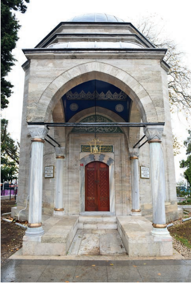
2019 yılında yapılan restorasyon sonrası
