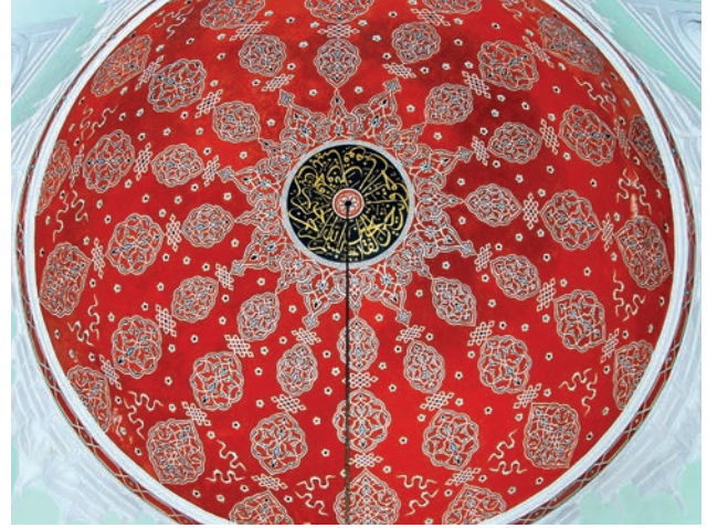
2013 yılındaki restorasyon öncesi kubbe içi
